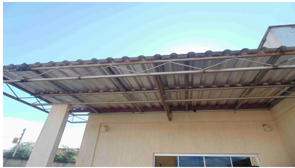
Foto 07 - Vista geral do telhado da varanda frontal, que apresenta reforço estrutural em perfis metálicos ainda sem pintura anticorrosiva e esmalte sintético
