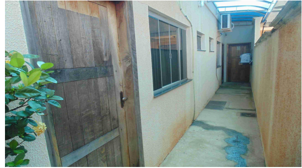
Foto 26 - Detalhe da porta de madeira do alojamento feminino, onde se observa a ausência de proteção com pintura interna e externa em verniz incolor (fosco)
