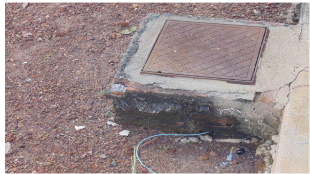
Foto 46 - Detalhe da caixa de passagem (elétrica), que deve ser mantida com a pavimentação proposta para a área central (garagem), junto ao bloco de alojamentos
