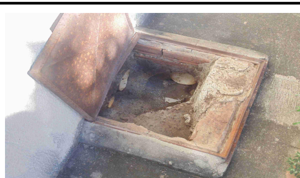
Foto 50 - Detalhe da caixa de esgoto mais próxima ao banheiro interno, devendo ser readequada em virtude do direcionamento do esgoto (bloco de alojamentos)
