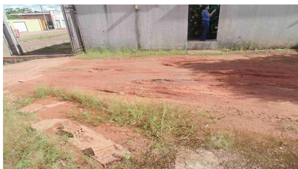
Foto 23 - Vista do pátio e portão de entrada lateral, sendo necessário o lançamento de aterro compactado, como base para brita zero ou bloquetes de concreto
