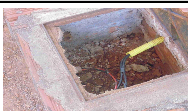
Foto 50 - Detalhe da caixa de esgoto mais próxima ao banheiro interno, devendo ser readequada em virtude do direcionamento do esgoto (bloco de alojamentos)
