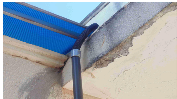
Foto 16 - Detalhe da fixação do eletroduto externo de aterramento da edificação, proveniente de serviços recentemente executados por empresa especializada
