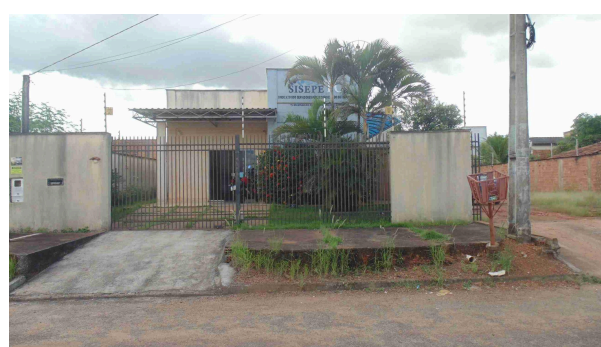
Foto 01 - Vista geral do Edifício Sede da Regional Sul em Gurupi, onde fora realizada a vistoria dos serviços previstos para reforma e adequação interna/externa
