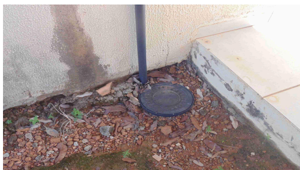
Foto 17 - Detalhe da caixa de aterramento (CA), onde faz-se necessária a execução de calçada (60cm) junto à antiga A. Serviço, visando o isolamento da referida CA
