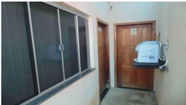
Foto 27 - Detalhe de paredes e portas de alojamentos, sendo indicada a pintura em verniz incolor (fosco) nas portas e pintura externa em tinta acrílica nas paredes
