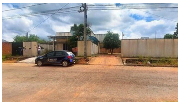
Foto 61 - Vista geral do Edifício Sede da Regional Sul, onde percebe-se a elevação da calçada externa em relação ao meio-fio e nível da rua (Foto: Eng a Solange)
