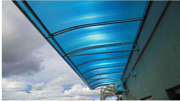
Foto 13 - Vista do toldo na circulação externa lateral, revelando a cobertura em bom estado de conservação sugerindo-se apenas a execução de pintura dos apoios
