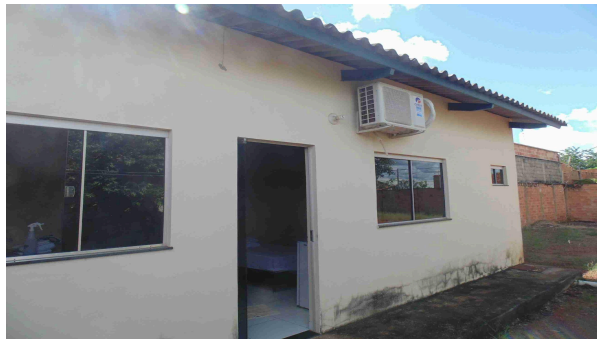
Foto 43 - Vista do bloco de alojamentos dos fundos, onde se prevê a instalação de garagem coberta com estrutura em perfil chapa dobrada e telhas metálicas
