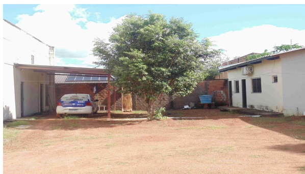
Foto 37 - Vista geral do pátio dos fundos, com vista do Edifício Sede da Regional Sul e garagem (à esquerda), além do bloco de alojamentos masculinos (à direita)
