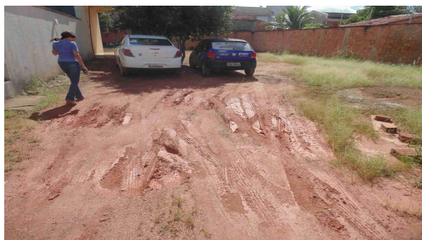
Foto 19 - Vista da entrada do pátio lateral, no interior do lote da Regional Sul, apresentando pontos de alagamento junto ao portão de entrada de veículos
